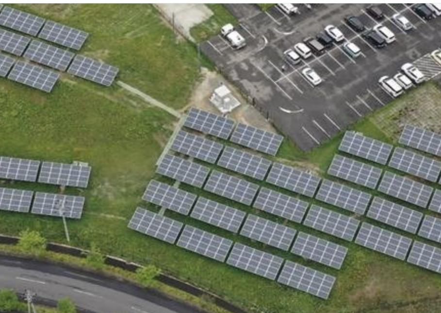
2020年7月、郡山工場の敷地の一部にNTTグループが所有する太陽光発電設備を導入しました。発電した電力を自家消費することで環境負荷低減を図ります。導入した太陽光発電設備より得られる年間想定発電量は502.8MWhで、郡山工場で年間使用する電力の約22%に相当します。
